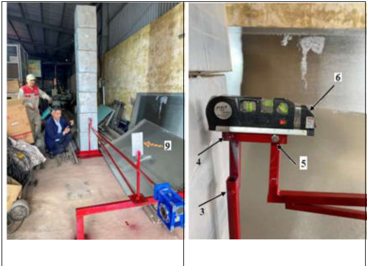
Hình 4.4. Hình ảnh thực nghiệm đo đặc hệ số nền nơi đặt đường ray xe goòng
